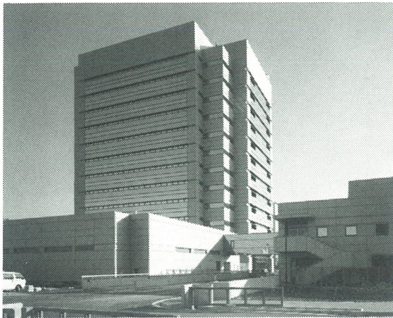
日本ガイシ株式会社 新本社ビル
